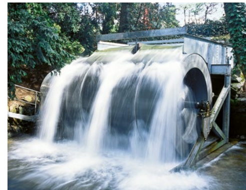
Wasserkraft-Anlage in Freiburg
