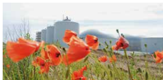
Von oben nach unten: Biogasanlagen Bremgarten, Forchheim und Neuried
